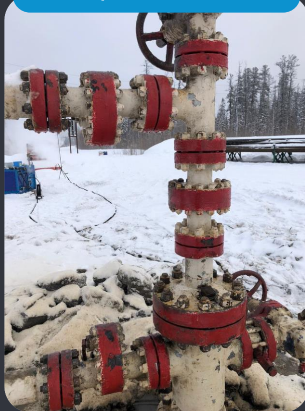
Заключительные работы после ремонта скважины
