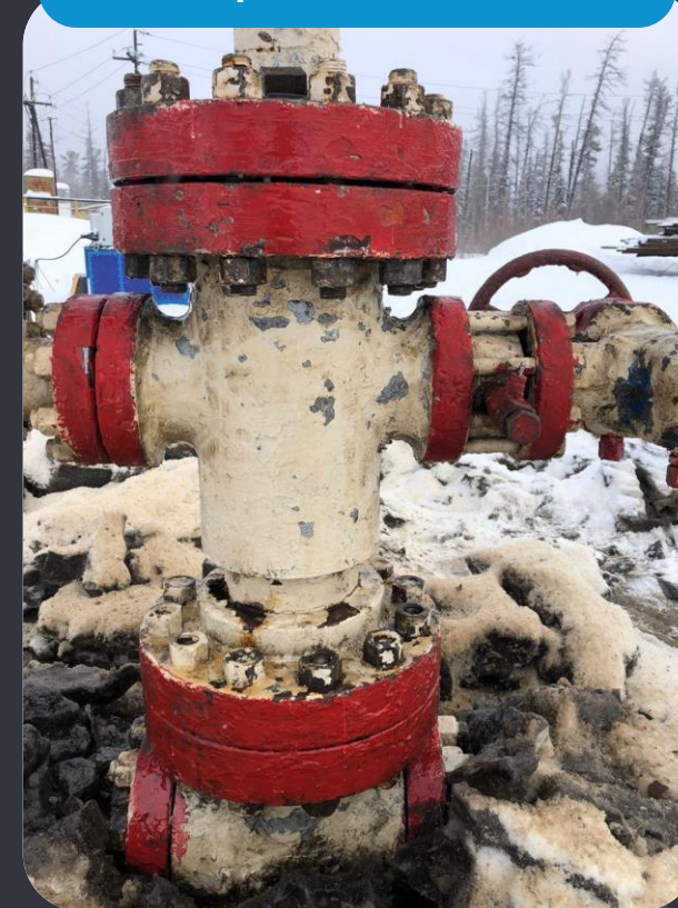
Заключительные работы после ремонта скважины
